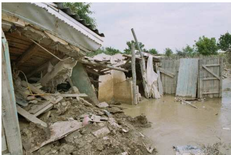
Inondations dans la vallée du Trotuş (BC) [Photo Christiane Béguin]
