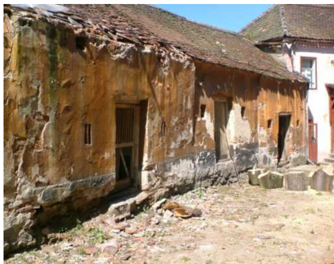
Etat des chambres avant les travaux [Photo Ben Jager]
