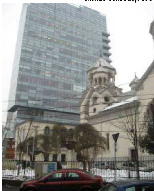
Figura 3. Biserica Armenească, monument istoric, sectorul 2, lângă care a fost lipit un turn de 18 etaje. Urmare a presiunii asupra solului, biserica a suferit trei crăpături serioase.
