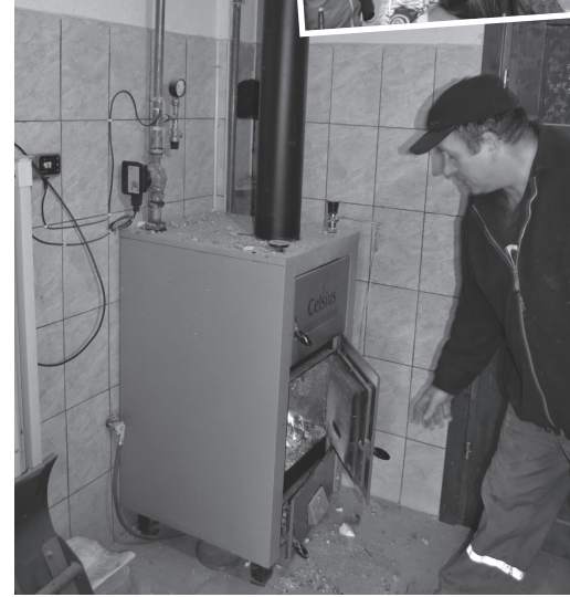
Une nouvelle chaudière et une nouvelle cheminée
